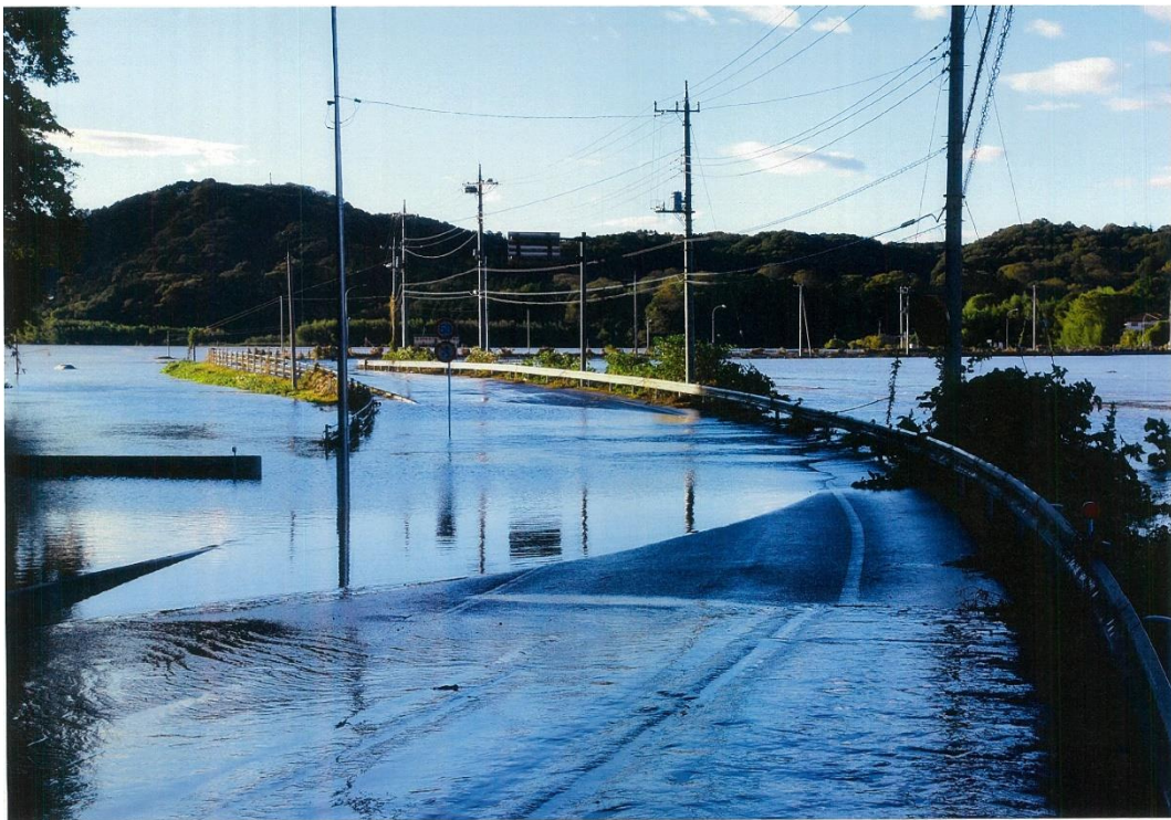
【本市における令和元年東日本台風の被災状況】
