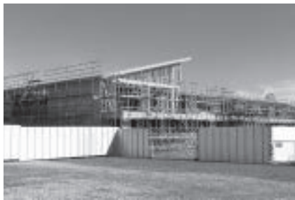
建設中の「なすからこども園」
