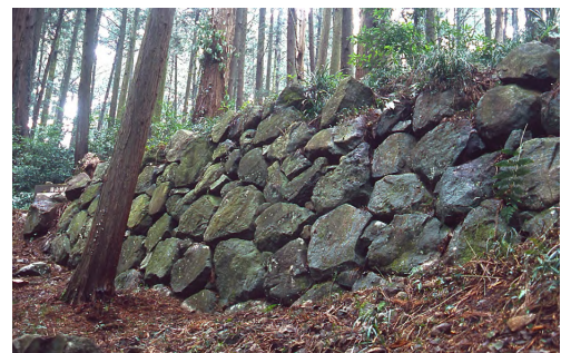
敵を阻むように城内通路に面して積まれた石垣
