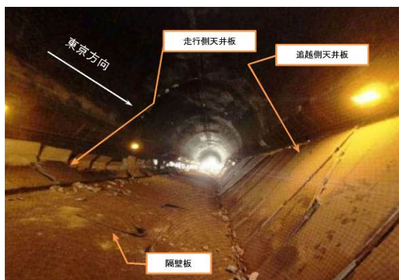
写真-3 天井板崩落状況①
