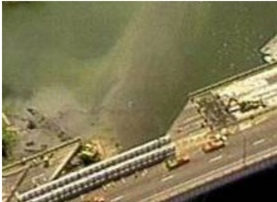
写真-1 マイアナス橋の落橋
