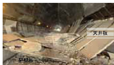
写真-4 天井板崩落状況②
