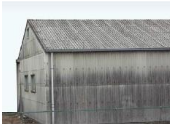
石綿含有スレート波板（屋根・外壁）
