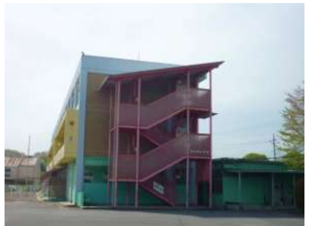
外観(外階段入口)
