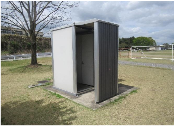
南側仮設トイレ
