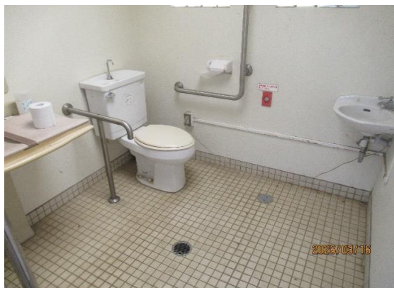
多目的トイレ(駐車場側)
