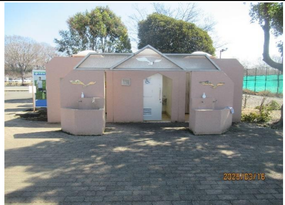
駐車場トイレ
