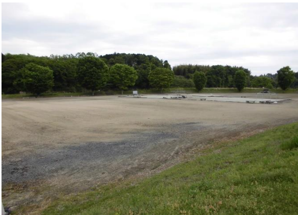
南那須運動場外観
