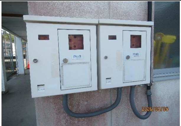
多目的競技場ナイタースイッチ(1階管理棟)
